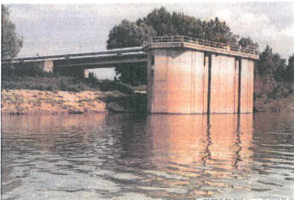
6. ábra Mederpilléres vízkivételi mű (Forrás: VCSM Zrt. Szolnok)
