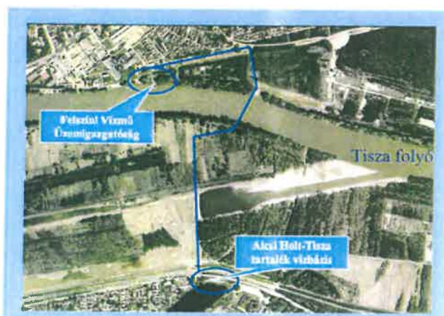
3. kép: A tartalék vízkivételi mű és a Felsővízi Vízmű elhelyezkedése
