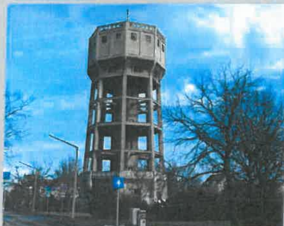
29. Eötvös téri víztorony MJSZ: 11558
